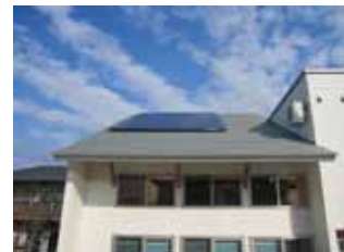
太陽光パネル
